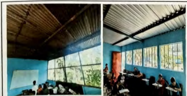
Foto 17: MODULO AULA A LA PAR DE MODULO DE PRE PRIMARIA. Vista Interior Se le dio mantenimiento a y estructura de metal y se sustituyo la lamina de zinc por lamina troquelada cal 26.
