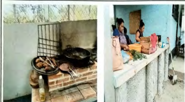
Foto 13: MODULO DE COCINA Vista exterior base de concreto al frente del modulo, con revestimiento de azulejo y tallado al frente.
