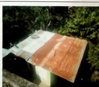
Foto 6: MODULO D Sustitucion de cubierta de lamina de zinc por lamina troquelada cal 26.
