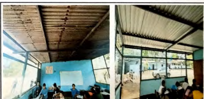
Foto 16: MODULO AULA A LA PAR DE MODULO DE PRE PRIMARIA. Vista Interior Se le dio mantenimiento a y estructura de metal y se sustituyo la lamina de zinc por lamina troquelada cal 26.Se aplico pintura en muros.
