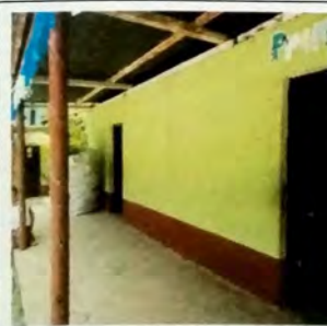
Foto 5: MODULO B Vista exterior Corredor. Se sustituyo la cubierta de lamina de zinc por lamina troquelada cal 26. Se le dio mantenimiento a las costaneras de metal.
