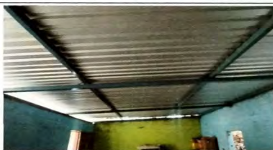
Foto 4: MODULO B Vista interior. Se sustituyo la cubierta de lamina de zinc por lamina troquelada cal 26. Se le dio mantenimiento a las costaneras de metal.
