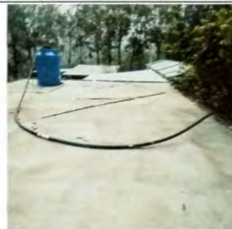
Foto 2: MODULO A Vista de losa que fue aplicado mezclon e impermeabilizante.
