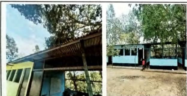
Foto 15: MODULO AULA A LA PAR DE MODULO DE PRE PRIMARIA. Vista Frontal Se le dio mantenimiento a y estructura de metal y se sustituyo la lamina de zinc por lamina troquelada cal 26.se aplico pintura en modulo.
