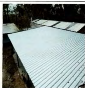
Foto 3: MODULO B Vista exterior. Se sustituyo la cubierta de lamina de zinc por lamina troquelada cal 26. Se le dio mantenimiento a las costaneras de metal.
