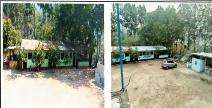
Foto 14: MODULO AULA A LA PAR DE MODULO DE PRE PRIMARIA. Se le dio mantenimiento a y estructura de metal y se sustituyo la lamina de zinc por lamina troquelada cal 26.
