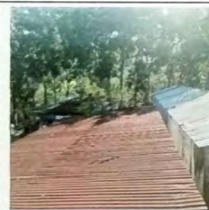
Foto 3: MODULO B Vista exterior. Se sustituyo la cubierta de lamina de zinc por lamina troquelada cal 26. Se le dio mantenimiento a las costaneras de metal.
